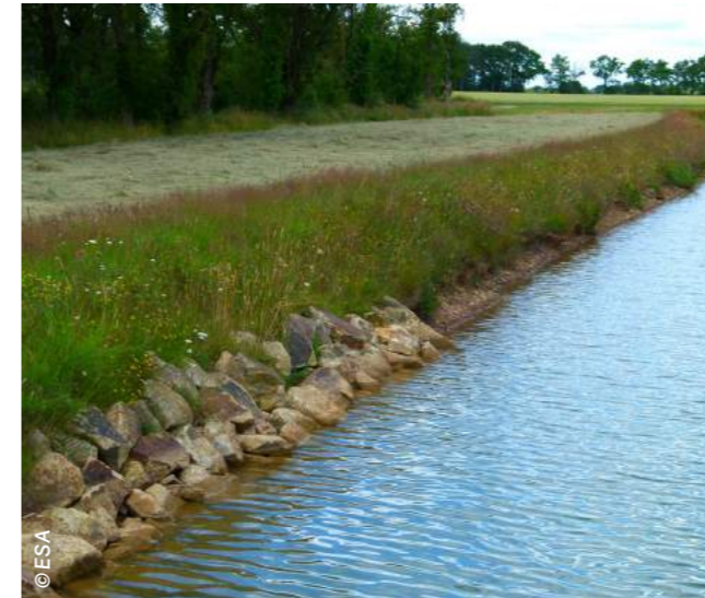
• Jachère fleurie en bordure de réserve d'irrigation et berges enrochées, Erdre-en-Anjou (49)
